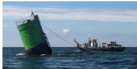
Instalación de Marmok en BiMEP
